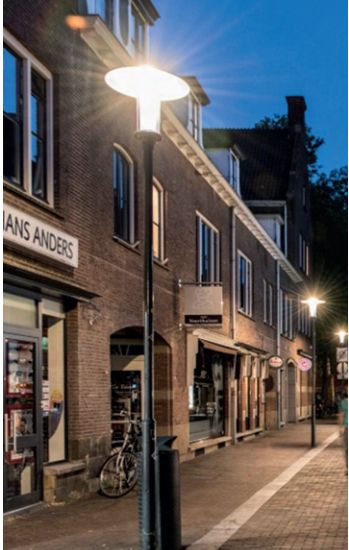
groene as conform Inverdan, type mast: paaltop mast: conisch naadloos getrokken hoogte: 3.5 m armatuur: Schreder Starlight LED
