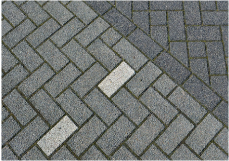
parkeervakken conform Wiorz betonstraatstenen, keiformaat, kleur zwart, elleboogverband tussen vakken witte stenen, om en om leverancier: Struyk Verwo of vergelijkbaar
