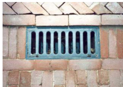
straatkolk in smalle molgoot molgoot in combinatie met straatkolk Poly C20 kolk, gietijzer bovenkop leverancier: ODS of gelijkwaardig
