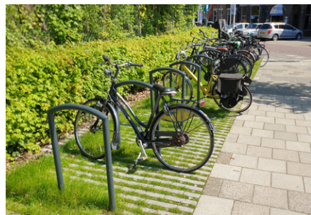
fietsparkeren school grasbetontegels
