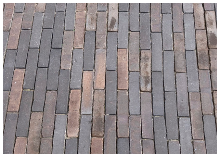
trottoir/looppaden conform Inverdan: gebakken klinker, waalformaat, type Inverdan mix onbezand, halfsteensverband leverancier Wienerberger
