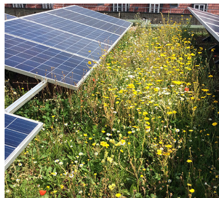
Zonnepanelen en beplanting voor daken uit het zicht ©Bauder. Clapham Par
