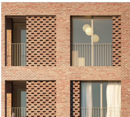
Een hoogwaardige gevelafwerking met zorgvuldig detaillering
