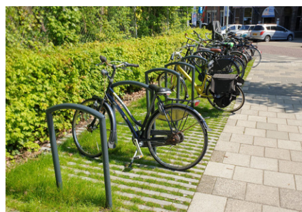
fietsparkeren school grasbetontegels
