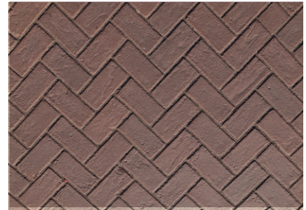
rijbaan zonder vrachtverkeer conform Wiorz betonstraatstenen keiformaat, kleur Baleno paars 550, keperverband. leverancier: Struyk Verwo
