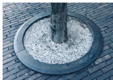
boomring gietijzer, buitendiameter 1m binnenkrans opvullen met schelpengrit type Edy leverancier: Samson
