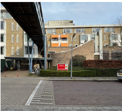
Huidige situatie van de hoofdentree met loopbrug en kapel
