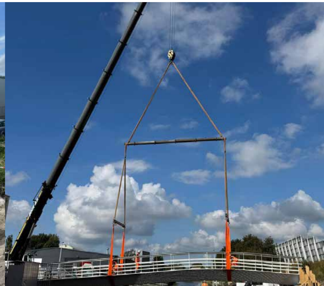
Inhijzen brugdeel Kippenbrug
