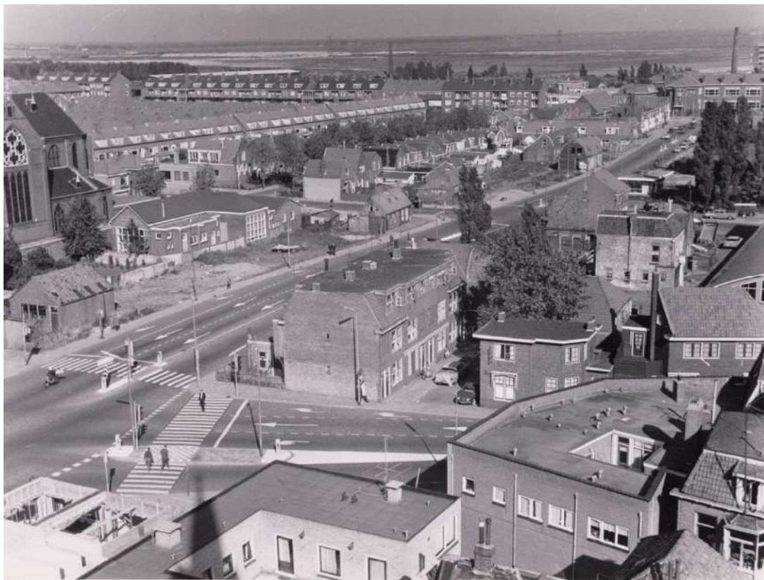
Overzicht van situatie voor bouw Beatrixflat ((GAZ 22.02206)
