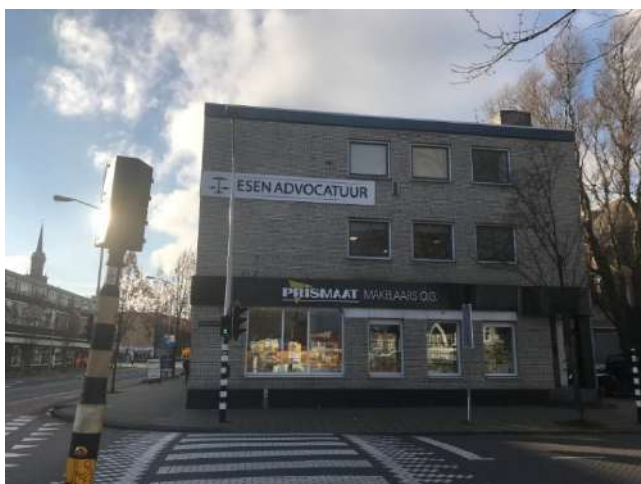
Deze hoekbebouwing is architectonisch niet waardevol en zelfs storend in dit deel van de straat.
