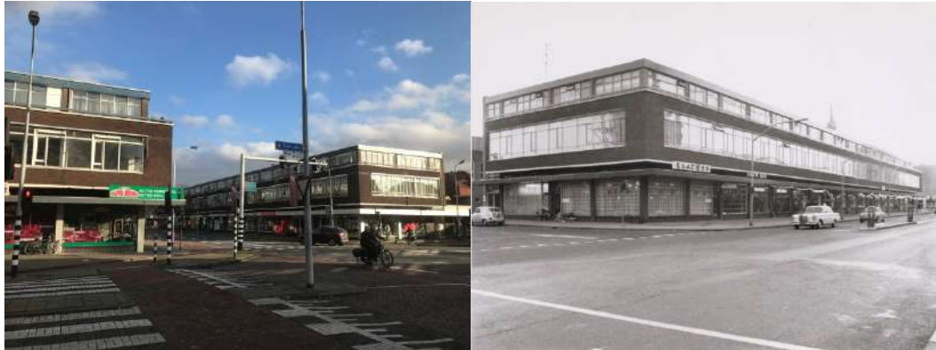
Blok 2 gezien met centrum in de rug. Aan deze zijde versterkt de gespiegelde architectuur elkaar. De blokken hebben een redelijke mate van gaafheid. De oude foto is van de andere kant genomen, maar laat zien dat er sprake is van redelijke mate van gaafheid (GAZ 22.02268)
