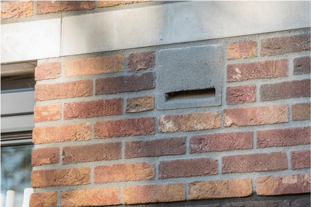
Figuur 10 Entresteen in een spouwmuur (Bron: Vivara)
