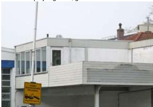
Kantoor boven carport aan de Westzijde
