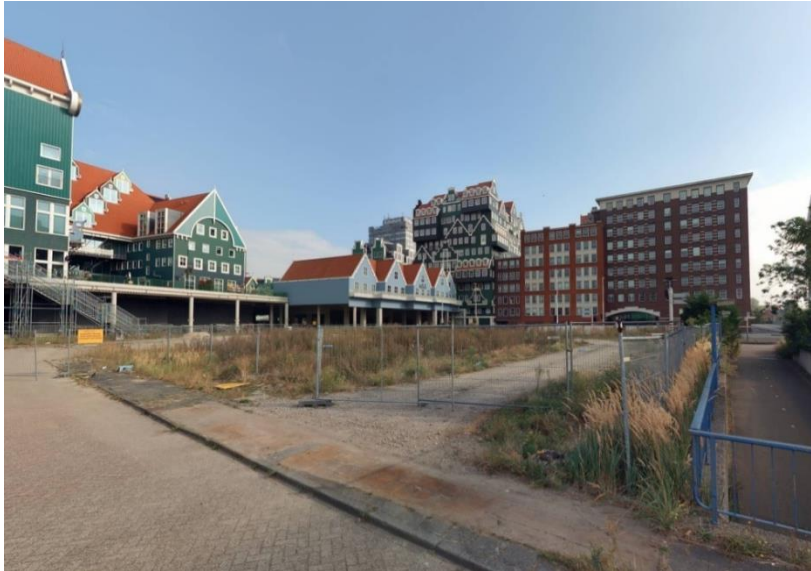
Figuur 2.2: zij aanzicht huidige situatie, in noordoostelijke richting
